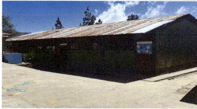
Foto1: Sustitucion de lamina, por lamina troquelada zinc calibre 26, aula 1, 2 y direccion con 164 m2
