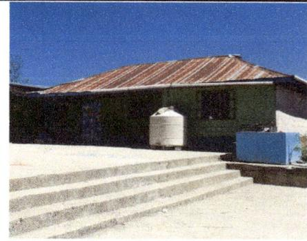
Foto 2: Sustitucion de lamina, por lamina troquelada zinc calibre 26, aula 1 con 63 m2
